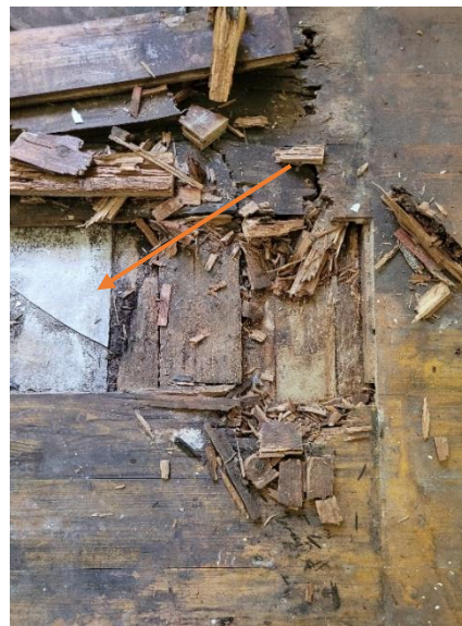
Foto 42 Angefallter einfacher Holzbretterboden aus Federbrettern, darunter Solnhofer Platten, darüber teilweise PVC-Belag.
