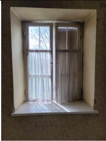
Foto 28 zwei Fenster Südseite
