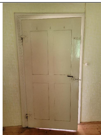
Foto 63 Türe Innenseite bauzeitlich
