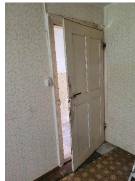
Foto 44 Bauzeitliche Türe evtl. vom Fletz versetzt
